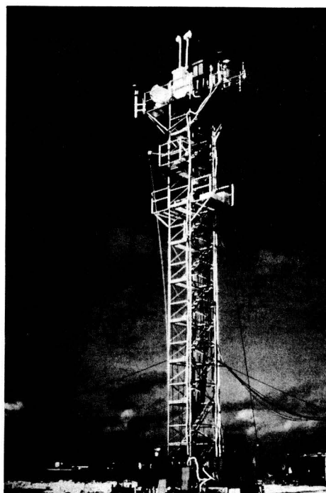
図1. シーレックス計画によって1979年にマーシャル諸島のエニウエタック島(北緯11.3度、東経163.3度)で建てられた高さ20mのアルミニウム製の組立式タワー。
